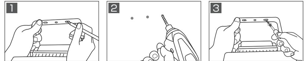
1 設置する場所に取付金具をあてネジ穴の位置にペンなどで印をつけます。
